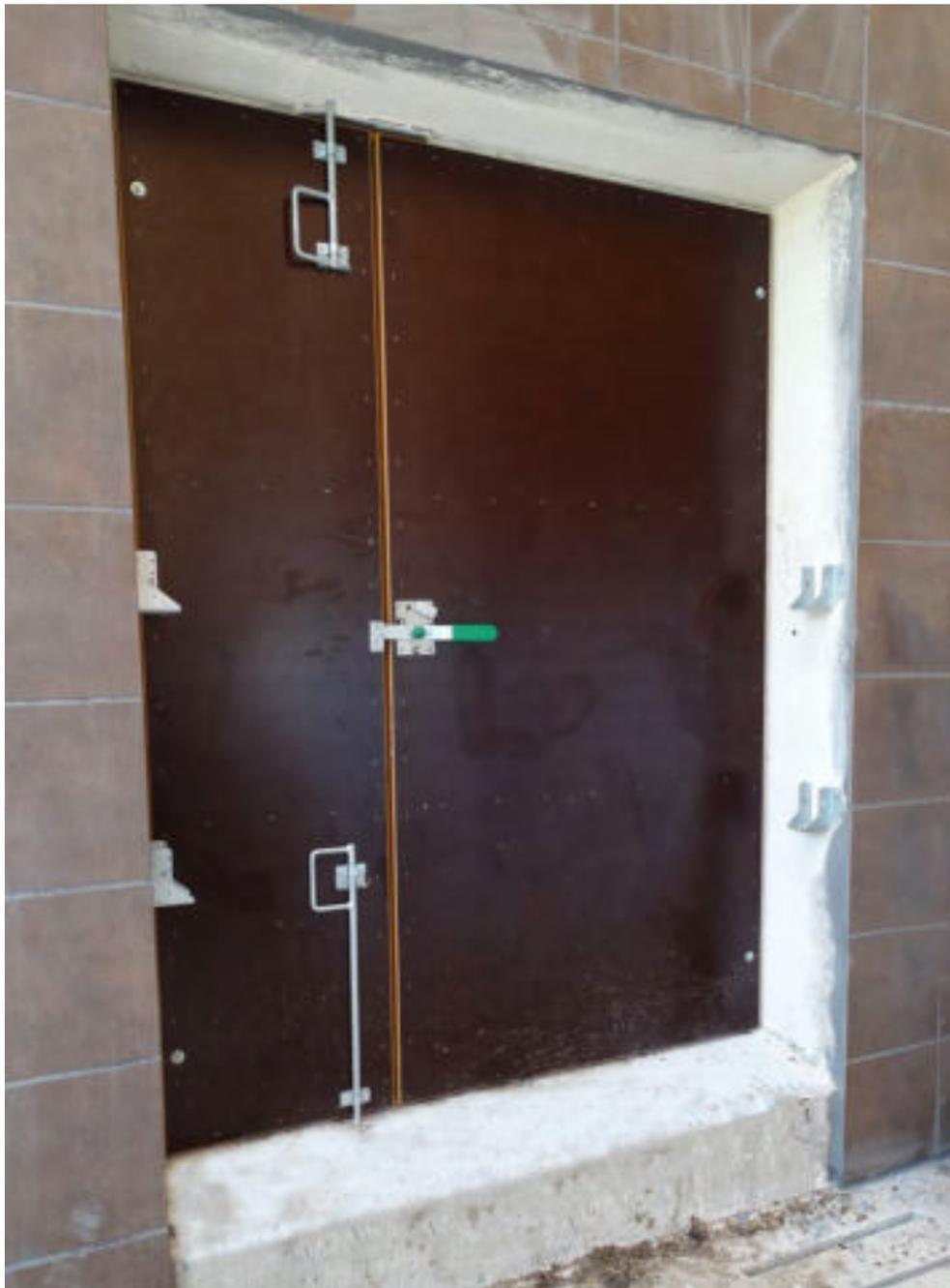
Bsp. Bild Innenansicht Flügeltor mit ALLEMANN® Torriegel oben und unten im Standflügel, ALLEMANN® Zuhaltung im Gehflügel
