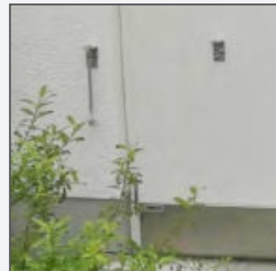
Windhaken aus Stahl, feuerverzinkt, zur Arretierung der Torflügel an der Wand
