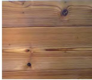
Thermofichte Blockwand geschliffen
