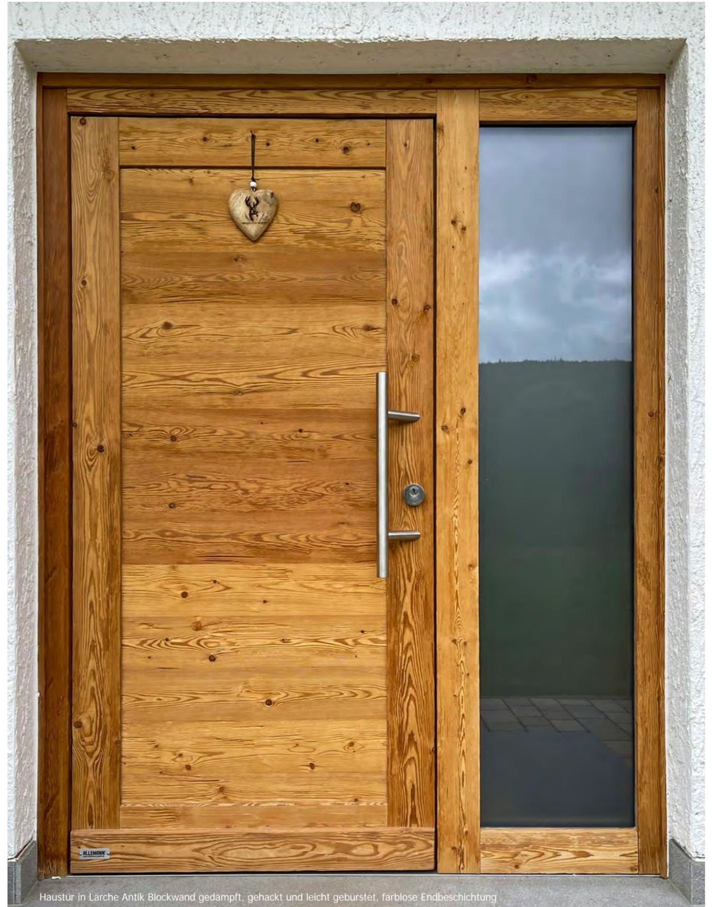
Haustür in Lärche Antik Blockwand gedämpft, gehackt und leicht gebürstet, farblose Endbeschichtung
