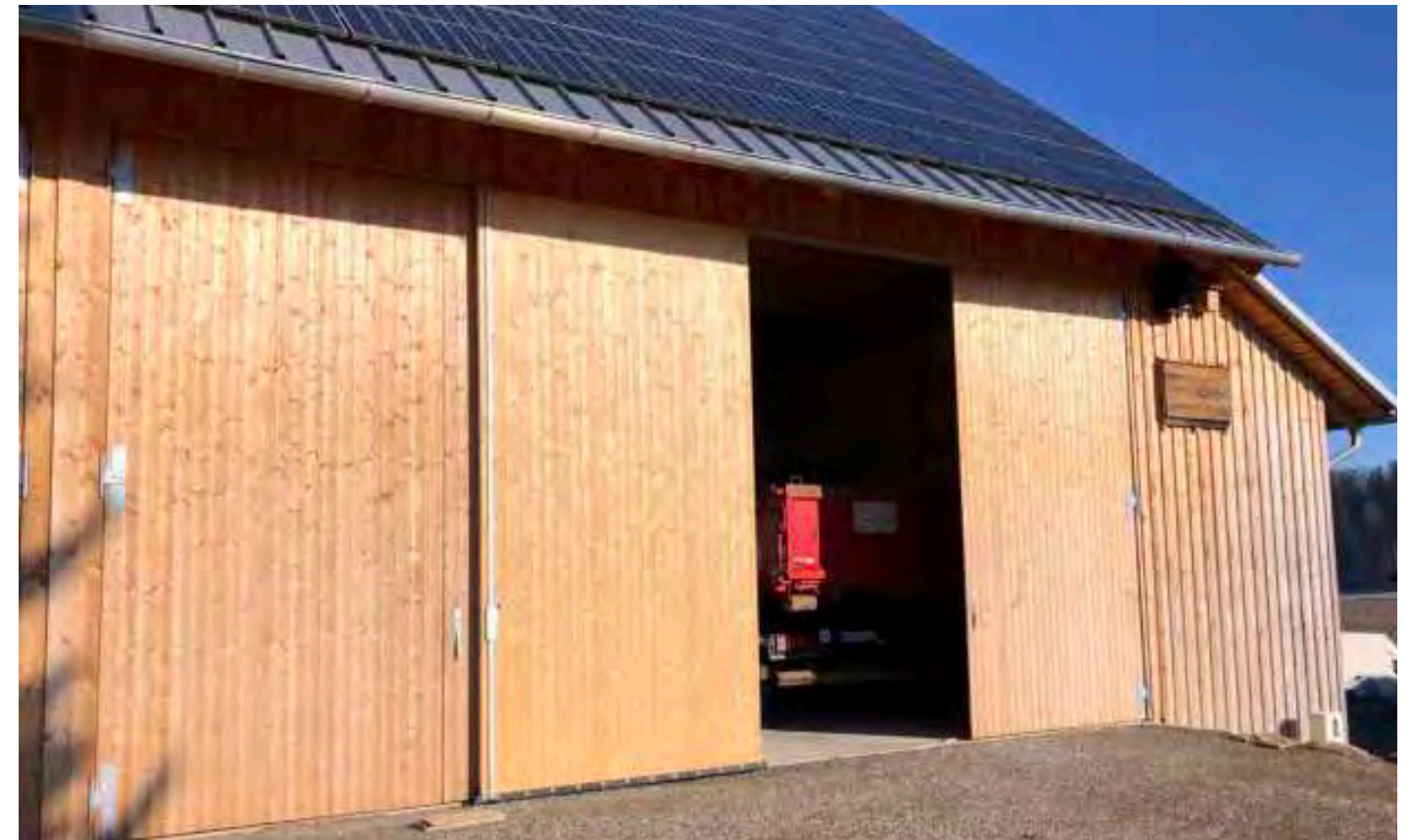
Flügeltor Typ 3.0.0 senkrecht in Fichte Natur Softline geschliffen, Metall-Z-Zarge, Konstruktionsbänder, beidseitig bedienbarer Schwenkriegel
