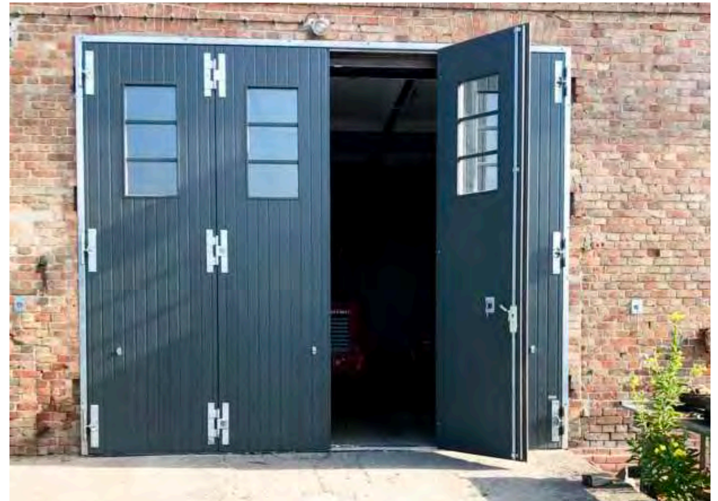
Mehrflügeltor als Werkstatttor mit verstellbaren Konstruktionsbändern in Fichte Softline, Endanstrich in RAL 7043 verkehrsgrau
