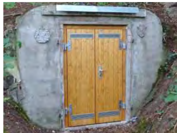
Flügeltor in Fichte mit Lüftungsöffnungen als Eingang in Erdkeller
