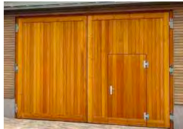
Flügeltor mit Durchstiegstür in Lärche
